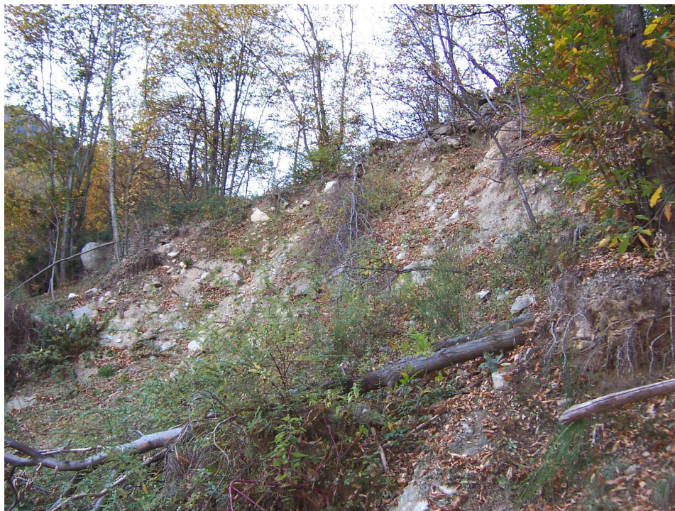
Sx idrografica T. Crezza- Loc. Bondio prima della sistemazione
